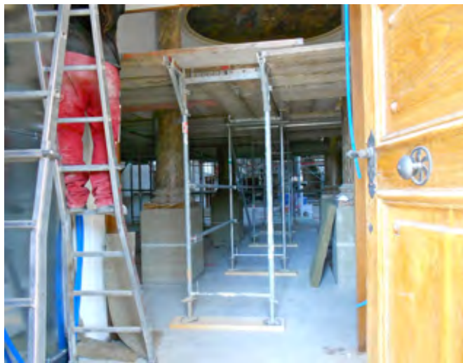
Blick in die Kirche während der Renovation. Bild fw
